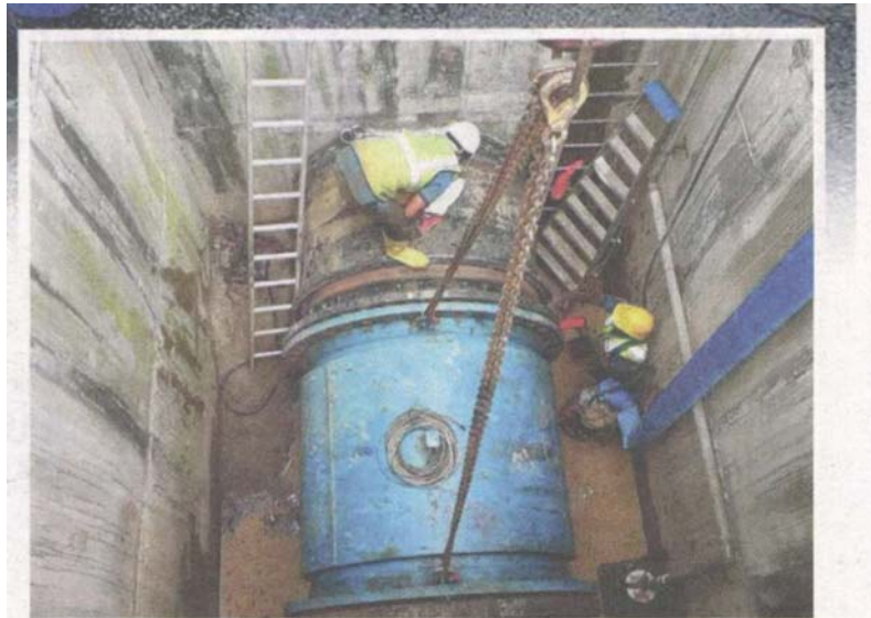
KERJA-KERJA penggantian peralatan kritikal di Loji Rawatan Air Sungai Semenyih, Selangor giat dilaksanakan.
